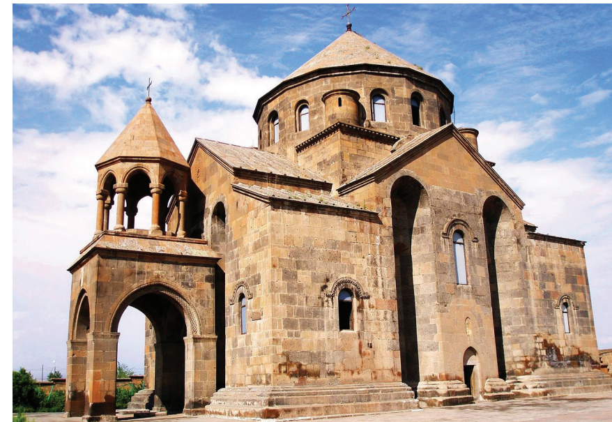
Şəkil 3. Əzizə Ripsime kilsəsi
